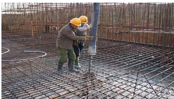
图1 混凝土的浇筑施工
