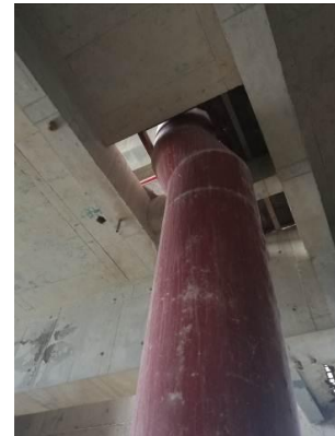
图八: 楼层中部间隔设置弯头
