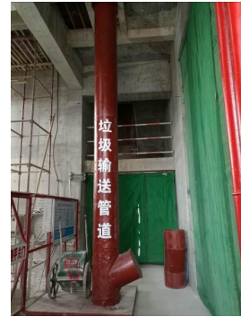
图六: 垃圾管道现场定位位置 (与图纸定位一致)
