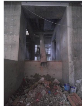
图七: 负一层垃圾管道及垃圾池设置
