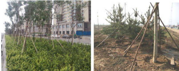
图 4.2 苗木栽植完成进行支撑
