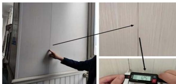
图1 石塑墙板实际应用中的尺寸收缩和开裂
